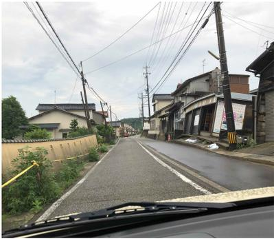
液状化が発生した内灘町では、電柱が斜めに立ち、道
